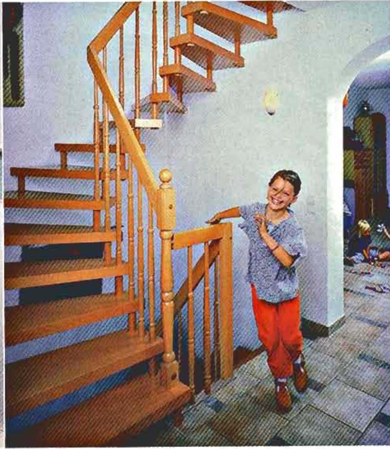
Specifická situace v domácnosti nastane tehdy, když je interiérové schodiště bariérou pro nejmenší obyvatele. Potom je rozumnější zvolit vertikální linii zábradlí s dostatečnou hustotou.
