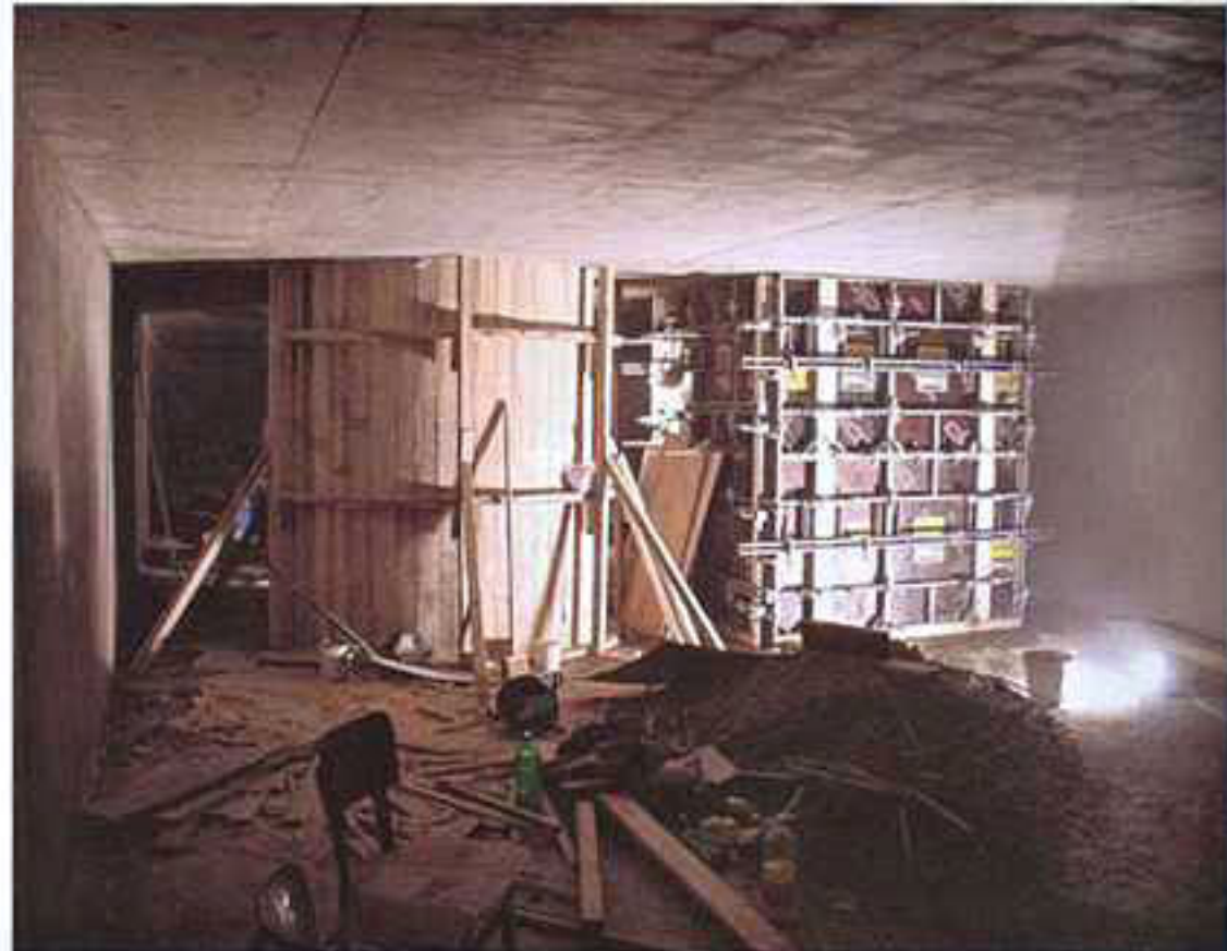
Bednění schodiště a výtahové šachty. Suterén, jižní část západního křídla. Formwork of staircase and lift shaft. Basement, southern part of the west wing.
